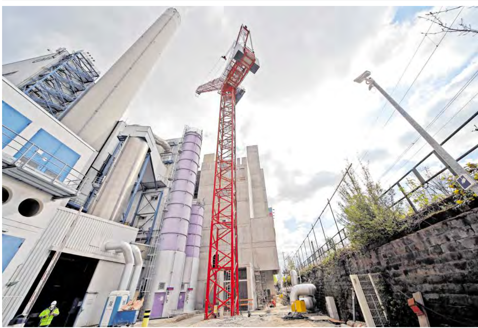
Der Schwerlastkran Wotan kommt beim Kesselbau im Gemeinschafts-Müllheizkraftwerk Ludwigshafen erstmals zum Einsatz.
