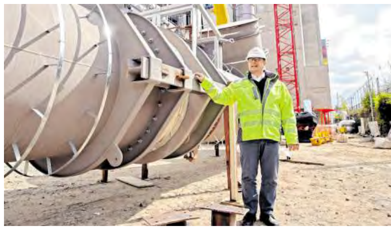
GML-Geschäftsführer Thomas Grommes steht neben einem sieben Tonnen schweren Teil einer Rauchgasleitung, das Wotan gleich an den Haken nimmt.
